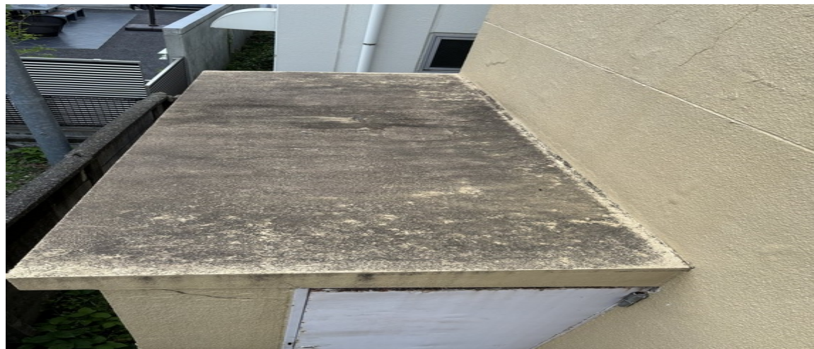
西面 電気室天端（現状：塗装仕上げ） 3.74 m 2
