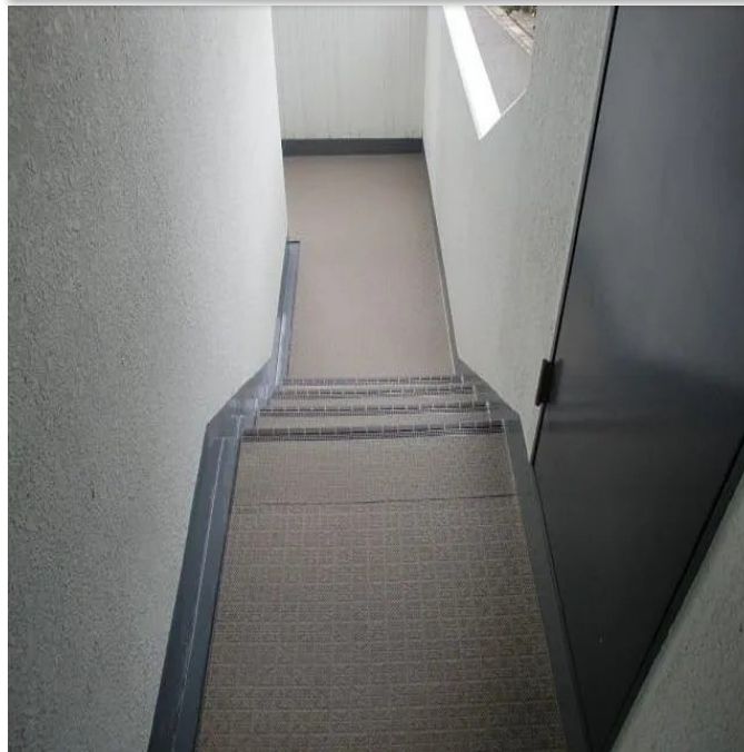
【仕上がり例】長尺ビニル床シート貼付完成イメージ
