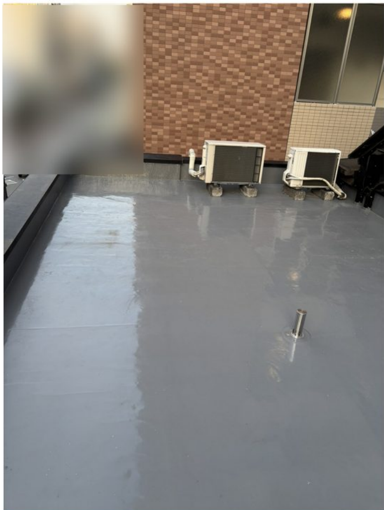
◆ 通気緩衝+ウレタン X-1 / X-2 + トップコート 仕上がり
