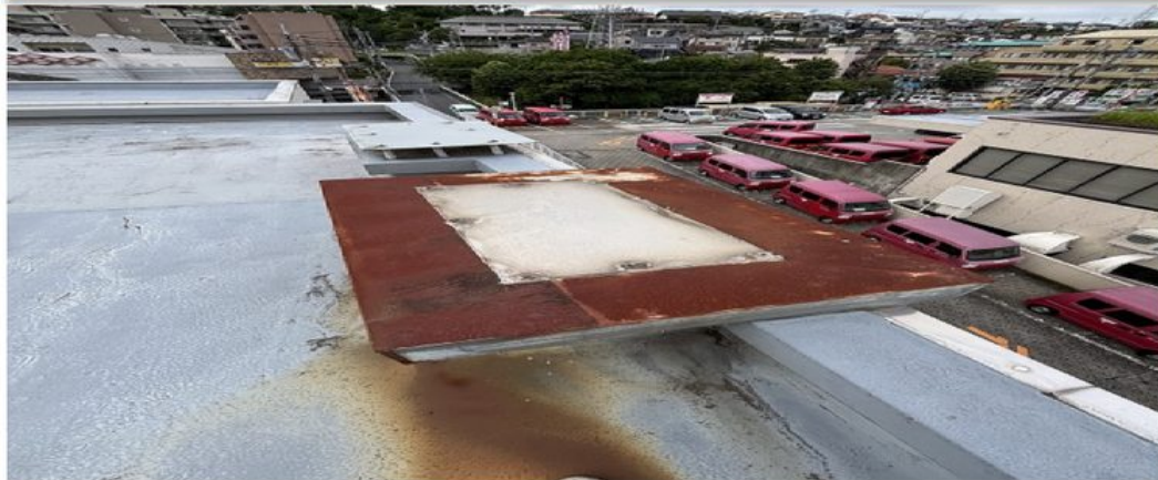
架台タイプ B (PS w1.2×1.2×h0.3) 4箇所 / 天端板金 → 脱着 必要
